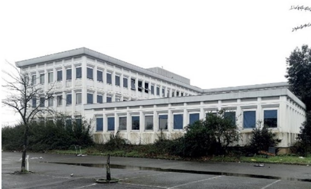
Anciens bureaux de l'Unedic à transformer
