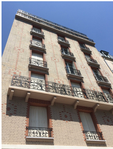
ensemble immobilier restructuré en résidence sociale et en pension la-Garenne (92)
