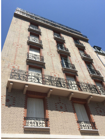
ensemble immobilier restructuré en résidence sociale et en pension la-Garenne (92)
