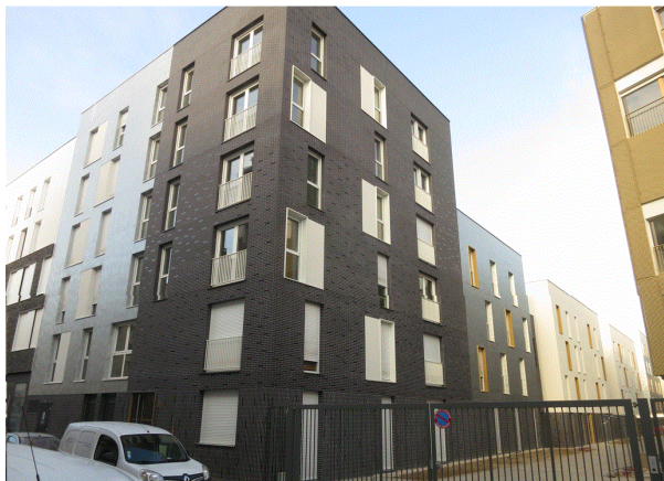
Logements sociaux à Aubervilliers (93)
