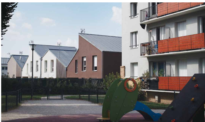
Bondy (93) : 16 maisons dans le cadre du projet de rénovation urbaine du 14-juillet Arch. : Verdier + Rebiere
