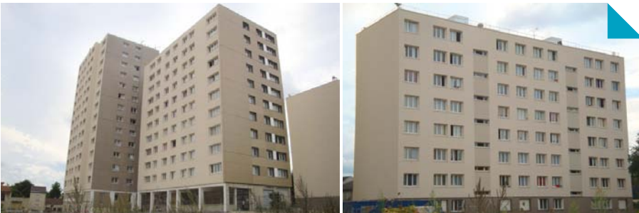
Les immeubles rue du château ont fait peau neuve
