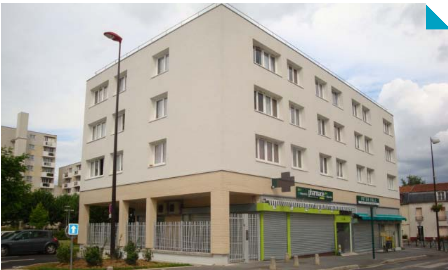
L'immeuble de la rue du 11 novembre est désormais complètement terminé
