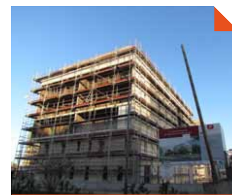
Première résidence à venir : le chantier est en cours
