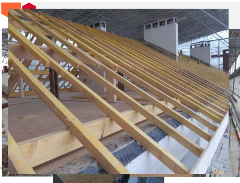
Villeneuve St Georges : durée des travaux 4 mois. Changement complet de la couverture
